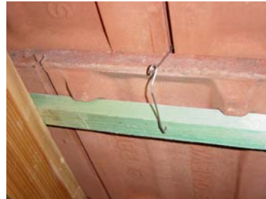
Photo 1: Crochet d'ancrage E-clips type 2 pour la tuile en béton STONEWOLD ROYAL
