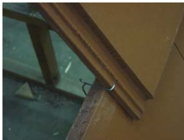
Photo 1: Crochet d'ancrage E-clips type 2 pour la tuile en béton STONEWOLD ROYAL
