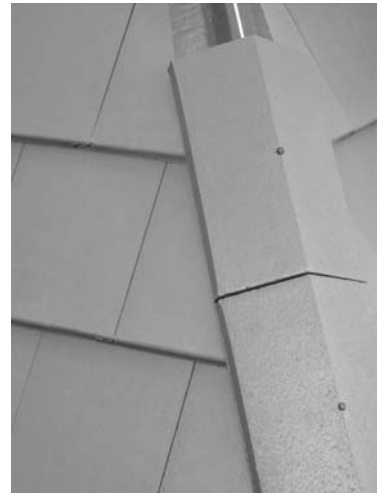
Photo 2: Finition d'arête avec faitière universelle angulaire
